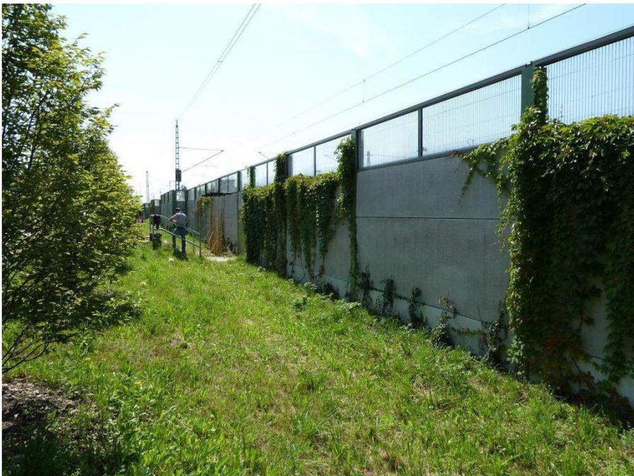
Abbildung 7.11: Bestehende Lärmschutzwand an Hochgeschwindigkeitsbahnstrecke nahe Mering
