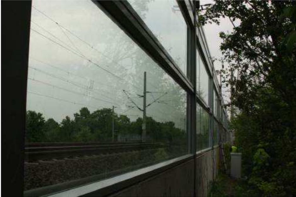
Abbildung 4.8: Transparente Lärmschutzelemente aus Mineralglas [80]
