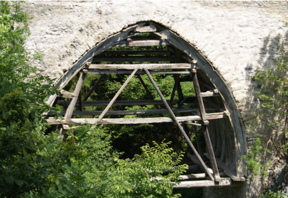
Brücke von Grins (Tirol) mit erhaltenem Baugerüst von 1639
