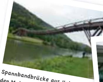
Spannbandbrücke aus Holz über den Main-Donau-Kanal bei Essing
