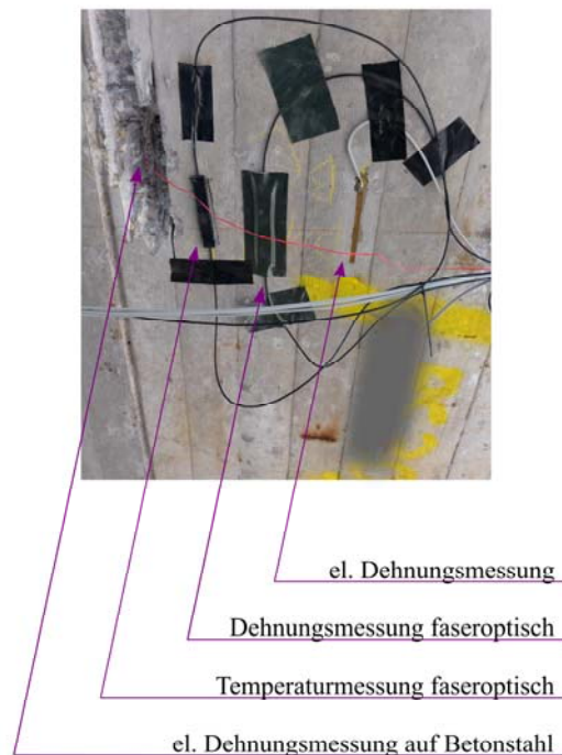
Abbildung 5: Angebrachte Dehnungssensorik an der Unterseite der Brücke aus [2]
