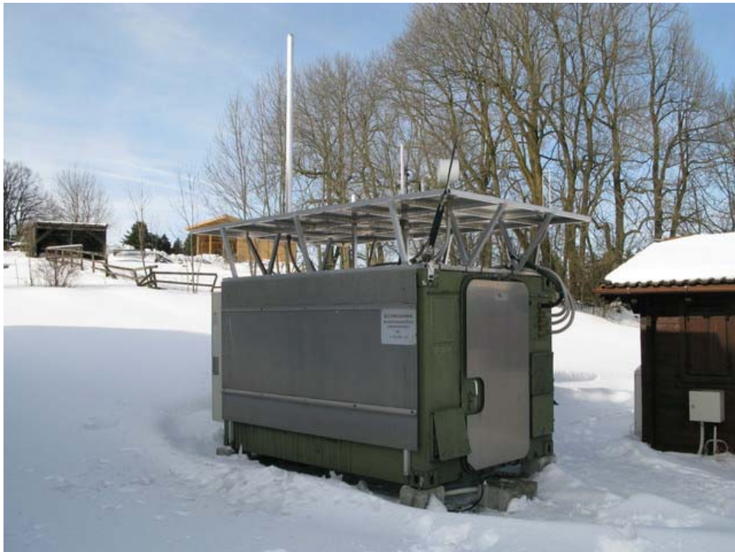
Bild 3.8: Feldmesskabine mit Dachkonstruktion
